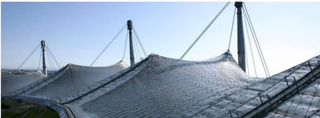
Abbildung 3: Dach des Münchner Olympiastadions.
